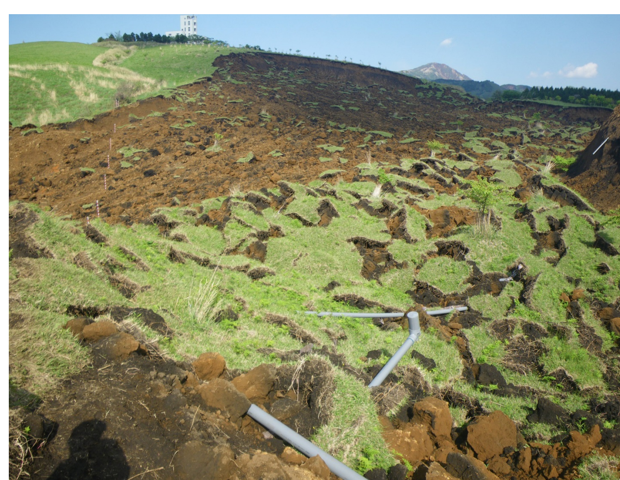
図4 京大火山研究センターの斜面崩壊①
