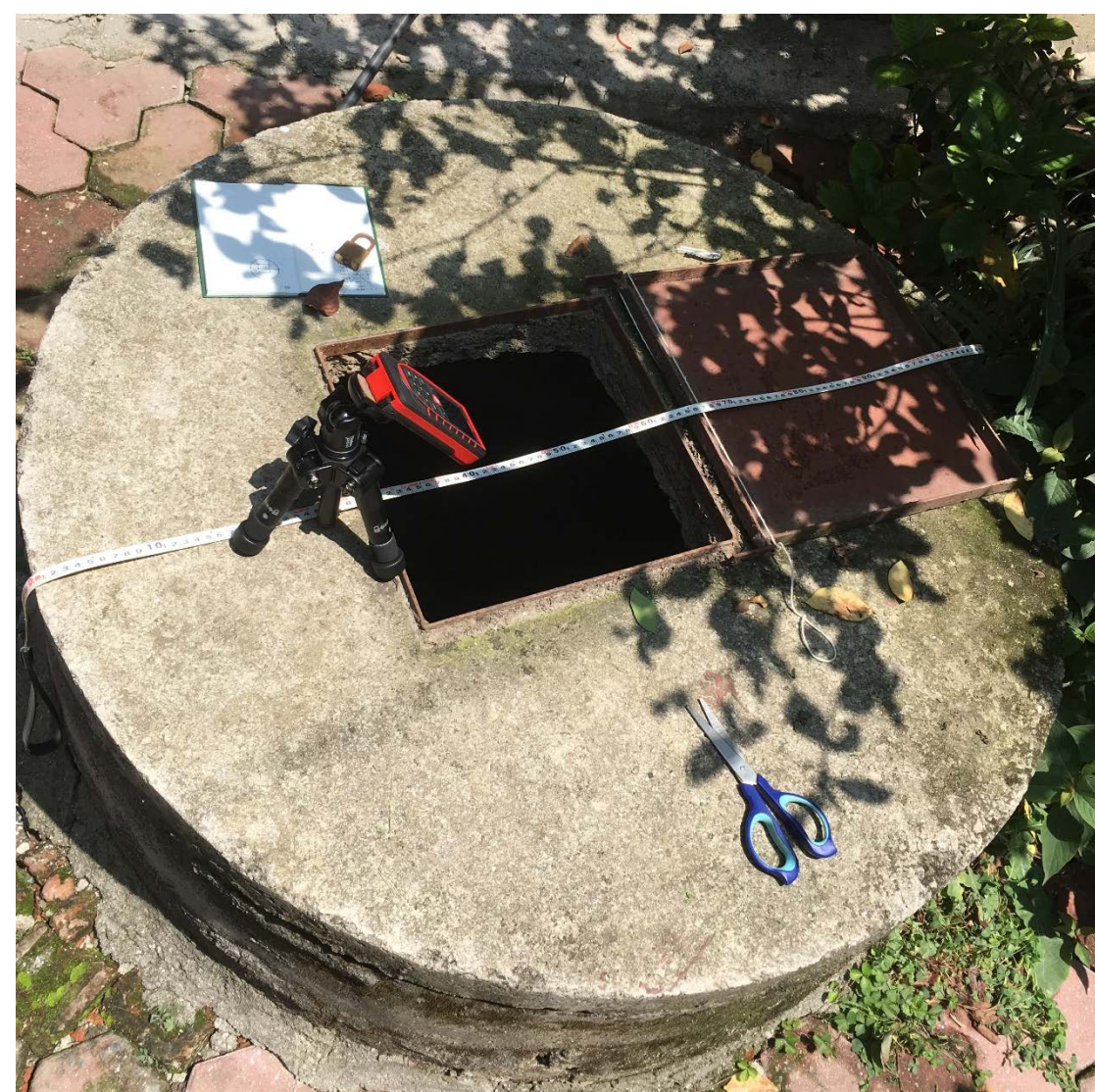
井戸の傾斜計測の様子
