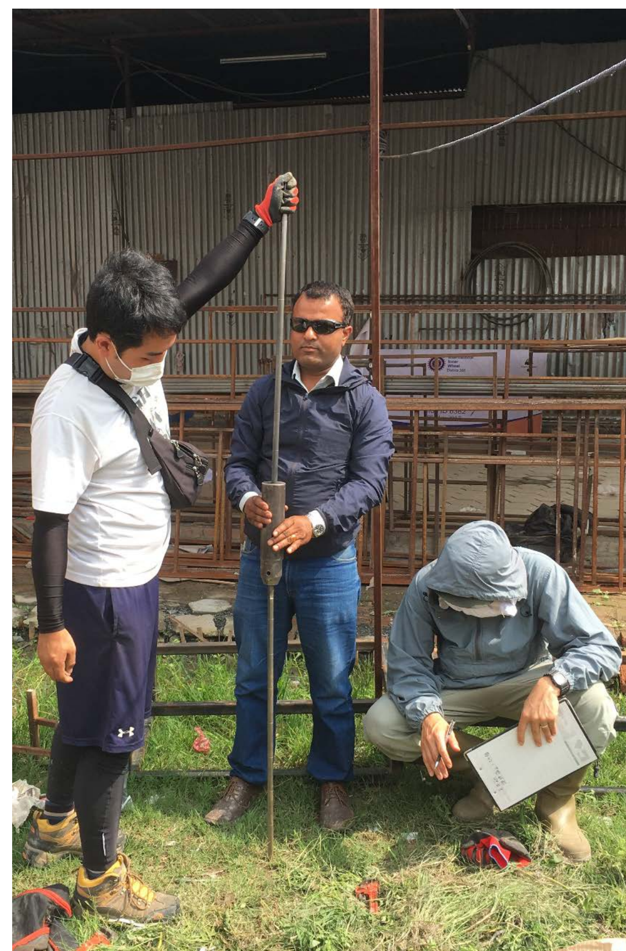
簡易動的コーン貫入試験の様子
