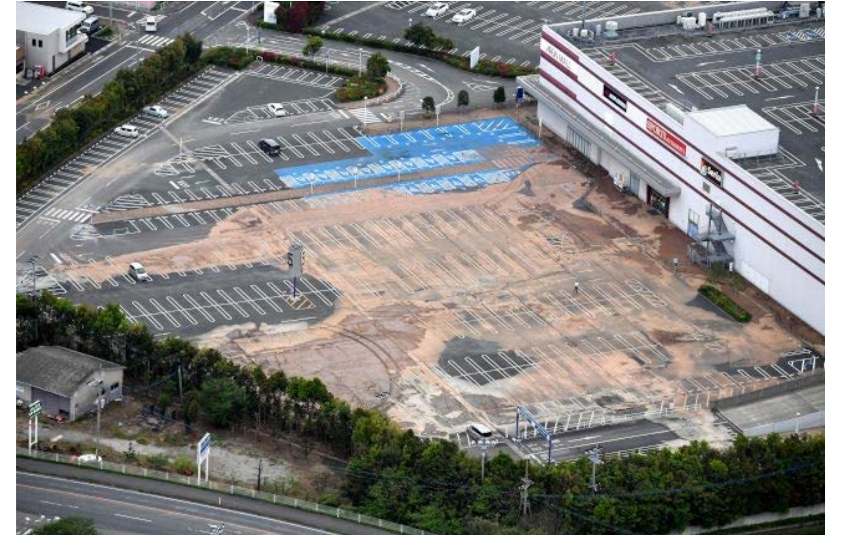
図1 熊本県嘉島町における液状化被害 (朝日新聞社)
